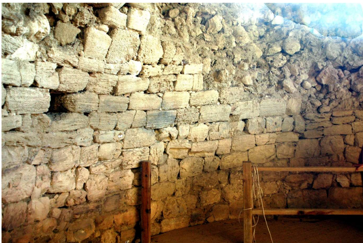
Εικ. 4. Λεπτομέρεια δομής του θόλου στο υψηλότερο σωζόμενο σημείο.
